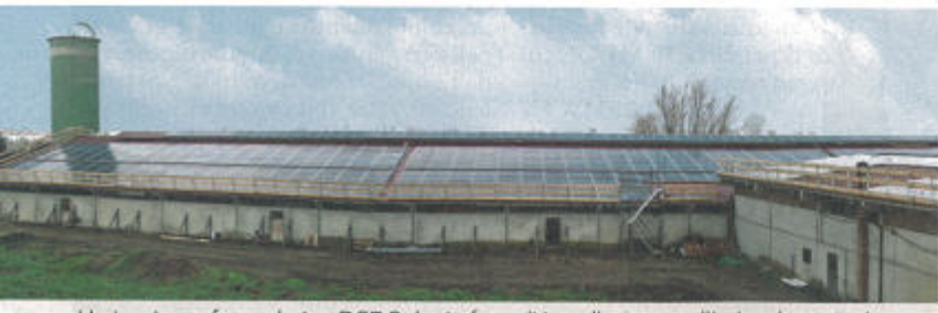
Un impianto fotovoltaico DSF Solar in fase di installazione nell'azienda agricola Tavazzani (Lardirago, Pavia)
